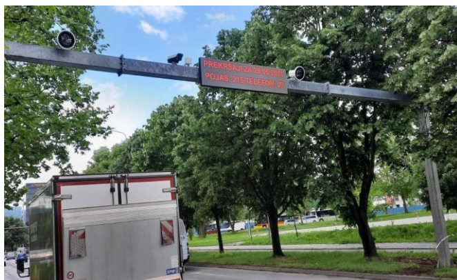
Слика 3. Бања Лука - Систем за детекцију и обавјештење о коришћењу сигурносног појаса и мобилног телефона
